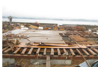
←2011年3月に発生した東日本大震災では、巨大な津波が発生して住宅を押し流し、写真のように基礎コンクリートと土台だけが残るケースが多く見られました。
